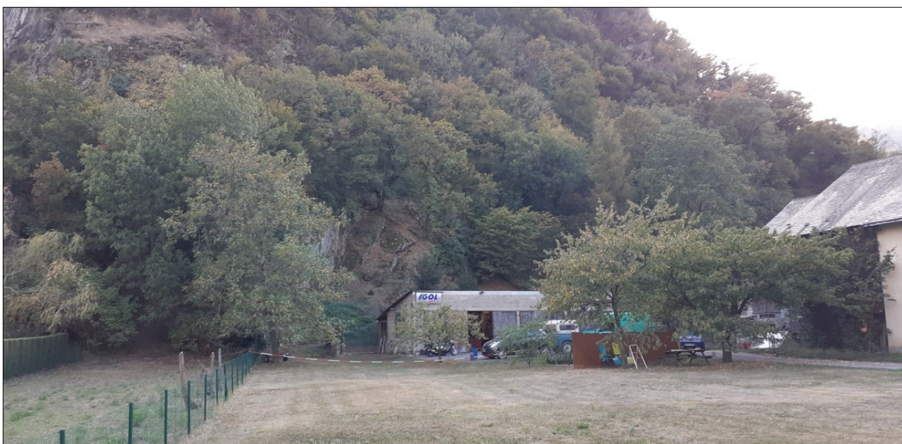
Figure V.4: Au nord du pointement, un atelier de réparation automobile paraît particulièrement exposé.
