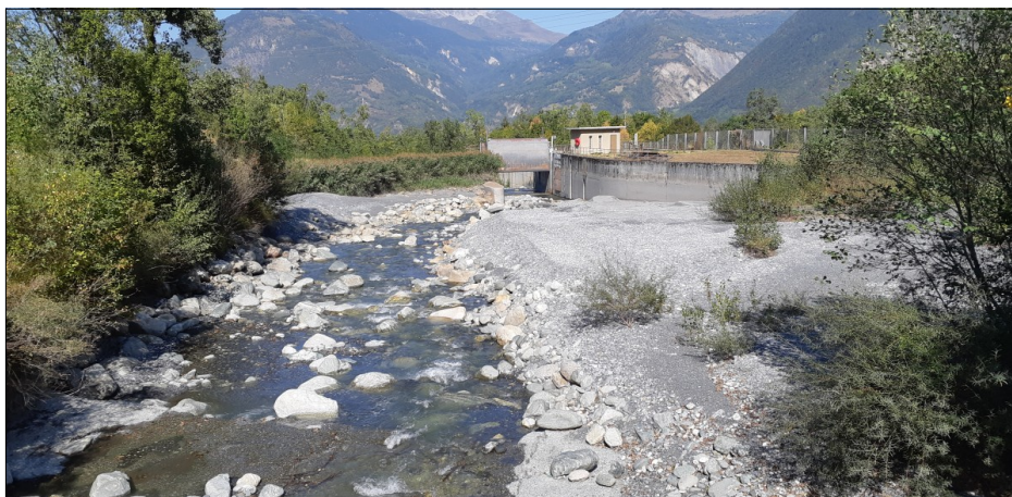
Figure V.17: Vue amont du seuil au niveau de l'usine EDF. On notera la forte sédimentation des matériaux à ce niveau du fait de l'élargissement du lit et de la réduction de la pente en long.
