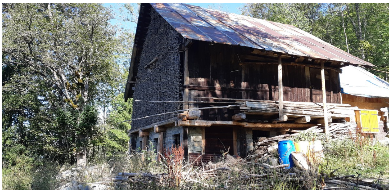
Figure V.8: Chalet et séchoir traditionnel en cours de restauration au Villaret.
