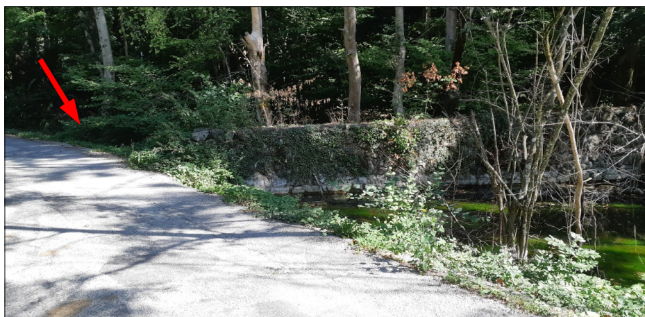
Figure V.19: Vue de l'extrémité amont de l'épi de Bonvoisin. On notera l'abaissement de la protection au passage de la route communale, probablement pour réduire l'effet de dos-d'âne.
