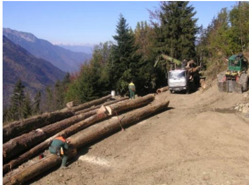
Chantier de Cubage-route de Plan Chapoteï
