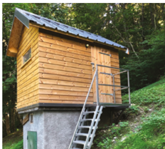
Un chalet en bois a été installé sur le réservoir pour protéger l'installation.
