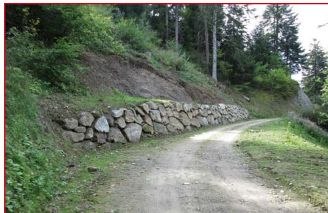
L'enrochement du talus longeant la piste
