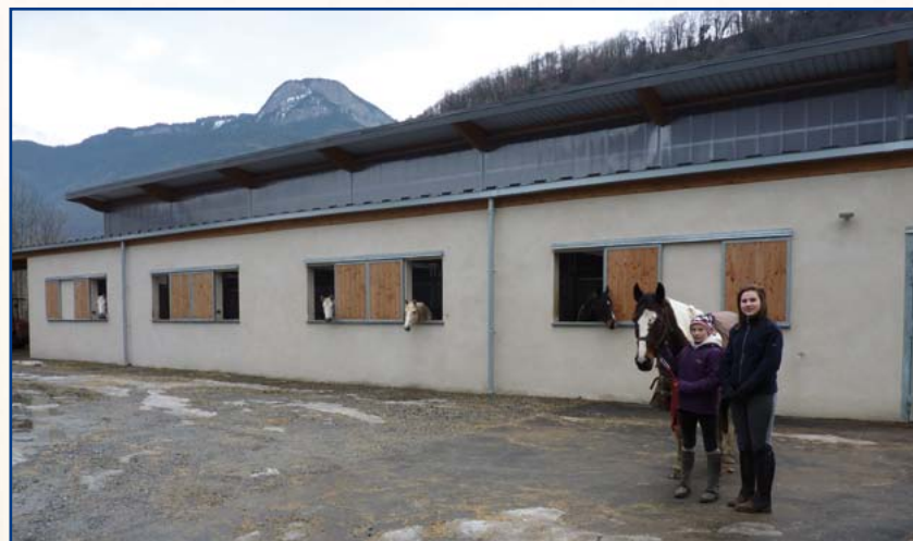
Vue arrière du bâtiment, Eline et sa monitrice nous présentent les pensionnaires du centre
