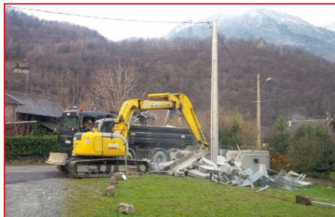
La démolition de l'ancien poste
